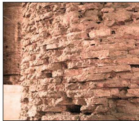
تصویر ۳. آسیب‌های وارده به آجرنما بر روی نمونه‌ای از ستون‌های گنبدخانه (مأخذ: نگارنده).
