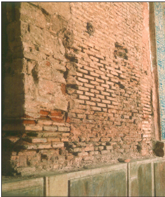
تصویر ۶. شوره‌زنی فعال بر روی آجرهای دیواره جنوبی گنبدخانه (مأخذ: نگارنده).
